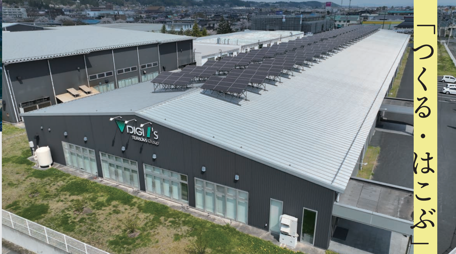
寺岡グループの国内生産拠点、株式会社デジアイズの岩手工場。 持続可能な生産消費を確保する仕組みづくりの一環として2013年よりソーラーパネルを導入。
